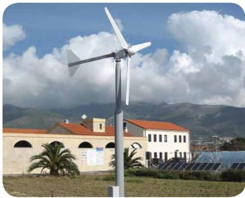
Generatore microeolico ad asse orizzontale installato presso il Cersaa di Albenga
