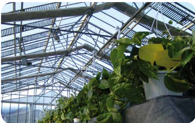
Veduta di prove sperimentali di coltivazione di Scindapsus sp. all'interno di serra fotovoltaica dotata di pannelli semitrasparenti CIS (Diseniuro di rame e indio) fotovoltaico presso il Cersaa di Albenga
