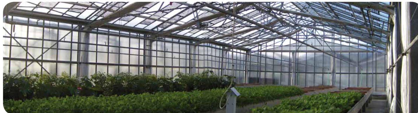
Veduta di prove sperimentali con diverse specie all'interno di serra fotovoltaica dotata di pannelli semitrasparenti CIS (Diseleniuro di rame e indio) fotovoltaico presso il Cersaa di Albenga
