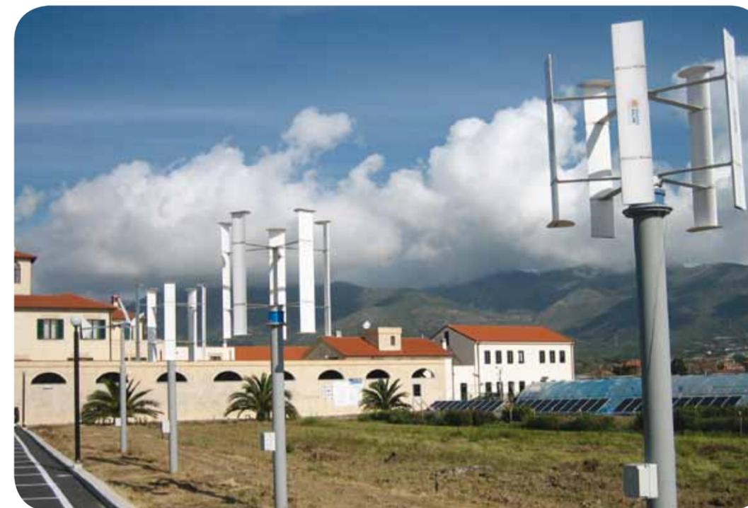
Figura 7. Aerogeneratori, impianto microeolico.
