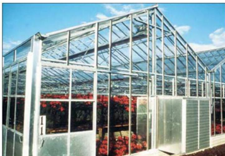
Figura 2-38: Esempio di Gutter-Connected Greenhouse
