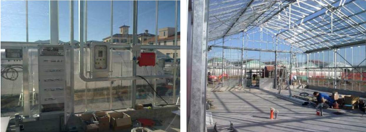
10. Realizzazione **impianto di illuminazione interna alla serra**, a norma di legge mediante: installazione di n.16 lampade LED ad ampio spettro VALOYA Grow Light temporizzate per l'illuminazione ottimale ad alta intensità delle coltivazioni con massimo risparmio energetico (n. 4 lampade/bancale); installazione illuminazione di servizio a LED (ditta DISANO)
