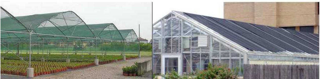
Figura 3-5: Esempi di barriere ombreggianti utilizzate nelle serre
