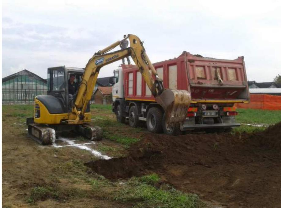
3. **Realizzazione delle fondazioni**, predisposizione dei cavidotti per il passaggio degli impianti e realizzazione delle reti di scarico, preparazione del piano di posa del pavimento elicotterato
