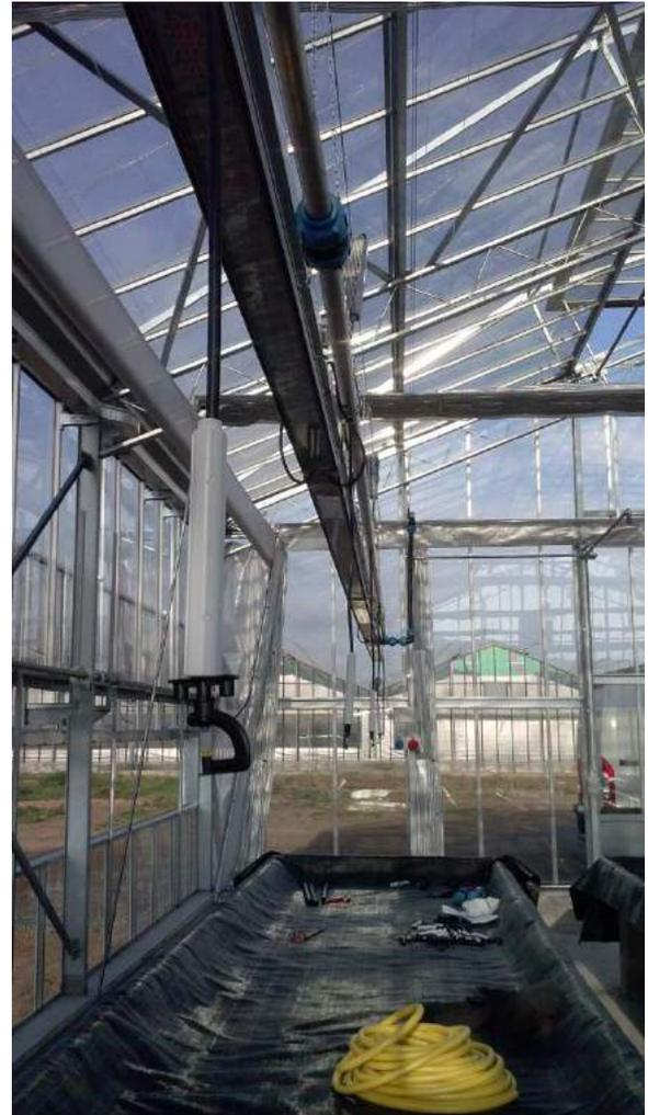
13. Installazione dei **sensori per il monitoraggio e il controllo** dei parametri climatici della serra (temperatura suolo/bancale, temperatura ambiente/sotto bancale, temperatura ambiente/altezza media sopra bancale, luminosità/sopra i led, umidità suolo/bancale) e centralina CPU
