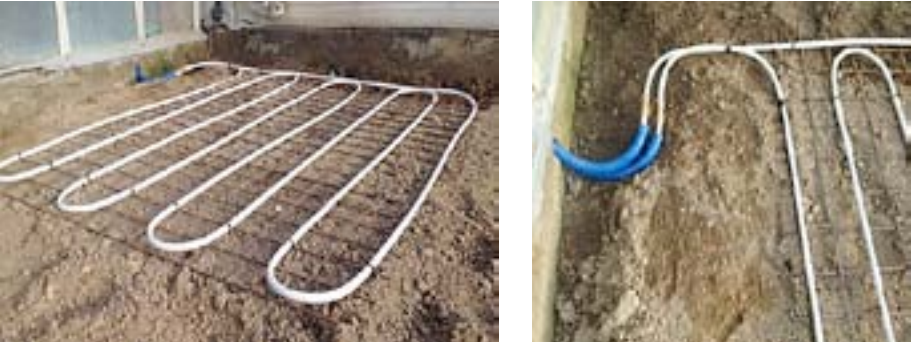
Figura 7. Impianto posto a terra prima del suo interrimento. È visibile la struttura del sistema a serpentina e del collegamento con i tubi di trasporto del calore.
