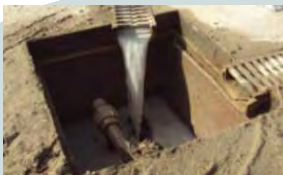
Pozzetto di raccolta delle acque nell'area attrezzata
