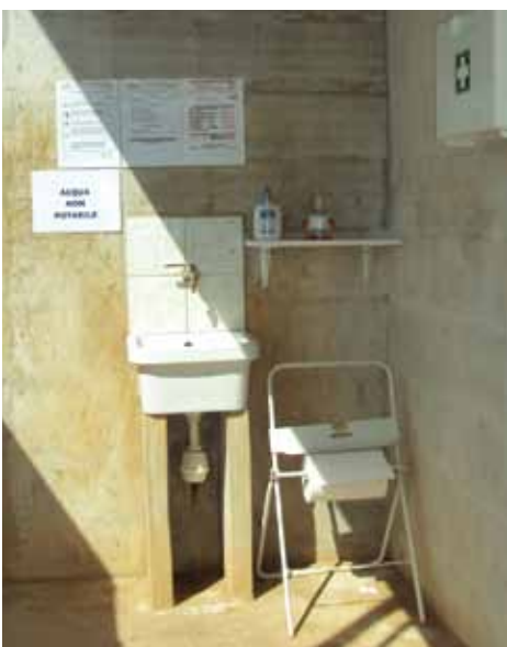
Lavello lavamani, procedure in caso di emergenza e kit di pronto intervento in area dedicata situata tra il locale di stoccaggio e l'area attrezzata
