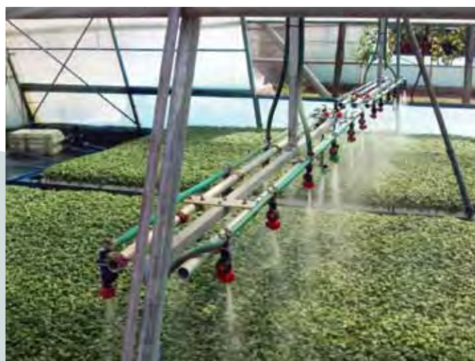
Applicazione con impianto fisso automatizzato (barra irroratrice)
