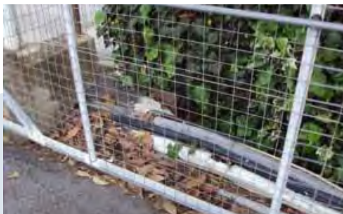
Tubazioni interrate provenienti dall'area di preparazione della miscela
