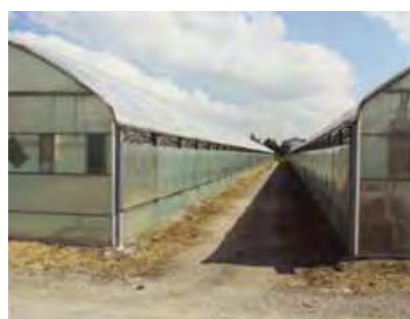
Finestra laterale a gravità con materiali rigidi
