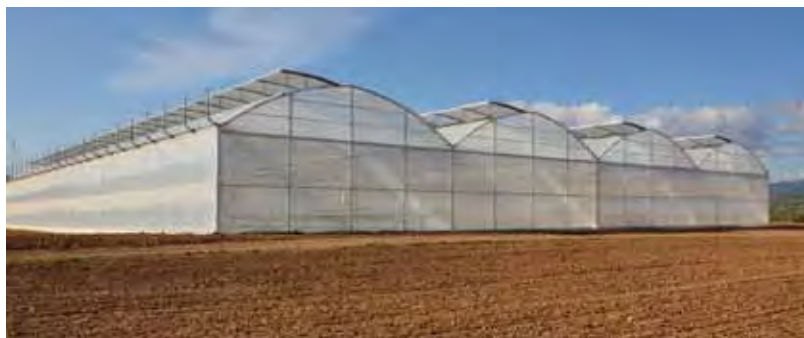
Serra a campata multipla con volta ad arco
